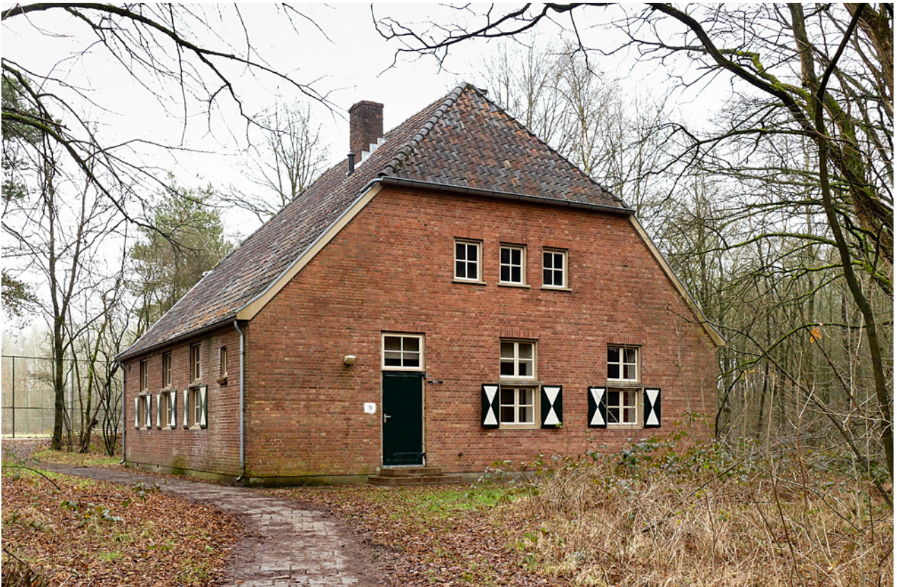
Legeringsgebouw voor manschappen op Groot Heidekamp. Dit gebouw heeft een middengang maar de ingang is meer op de hoek en komt uit in een halletje, een extra veiligheidsmaatregel die veel gebouwen op Deelen kennen.
